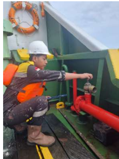
Pemeriksaan sambungan pipa hydrant
