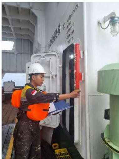
Pengecekan rutin safety fire plant dan denah lokasi letak pemadam kebakaran
