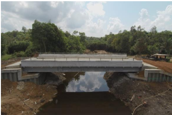
Jembatan Komposit Bentang 30 Meter, Jujah – Kalimantan Tengah
