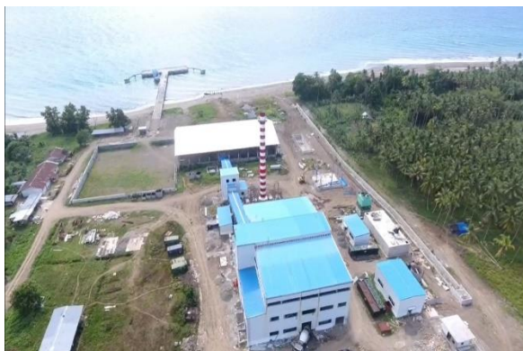
Pembangkit Listrik Tenaga Uap, Sofifi - Maluku Utara
