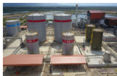
Stasiun Chemical Storage
