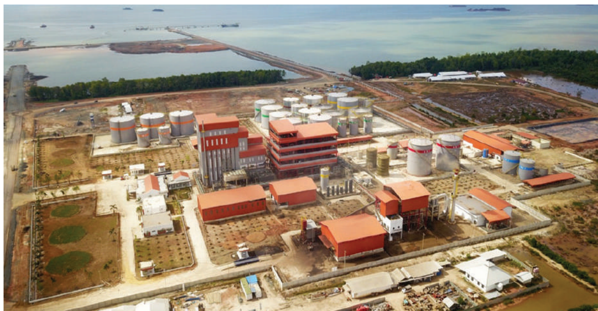
Kawasan Pabrik Refinery dan Pabrik Biodiesel
