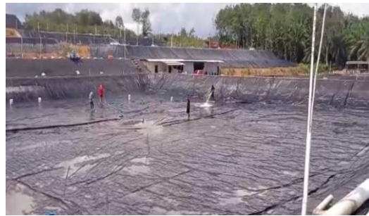
Pembersihan Kolam & Perbaikan
