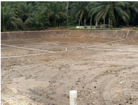
Pemasangan instalasi pipa dalam tambak
