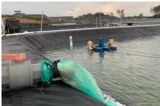
Persiapan Air & Pra-Tebar
